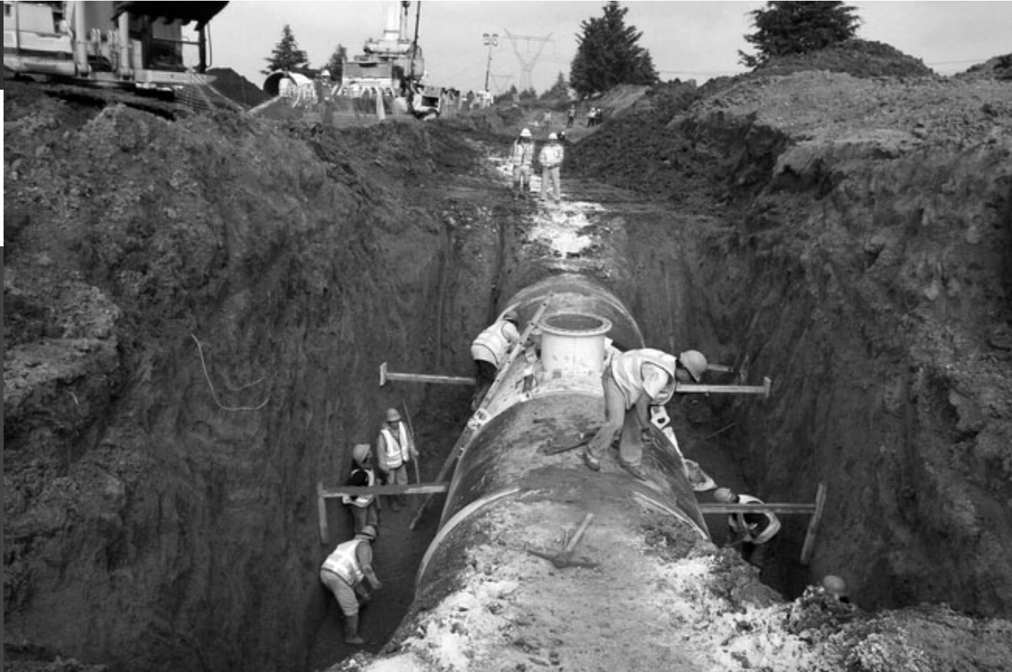
Construcción de red de agua potable principal.
